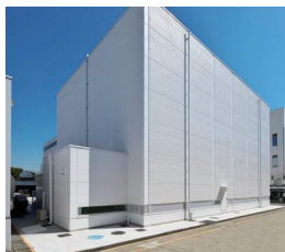
基礎 (土間) コンクリート 大成建設 技術センター 機械化施工のラボ 基礎 (土間) 工事
