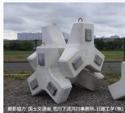
根固めブロック 荒川右岸堤防 関東地方整備局の公募事業にて実施
