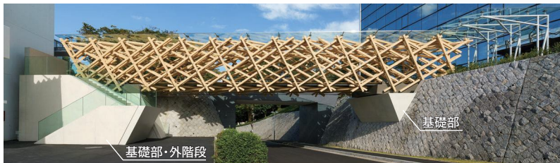
基礎部・外階段 大成建設 技術センター TAC.T BRIDGE
