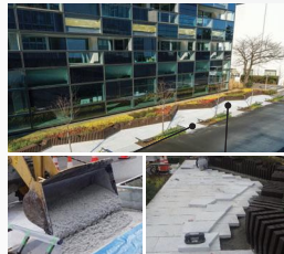
現場打ち舗装 舗装ブロック 大成建設 技術センター 人と空間のラボ前庭
