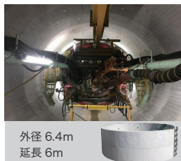
シールドセグメント 下水処理場シールドトンネル工事 発注者:海老江ウォーターリンク (株)
