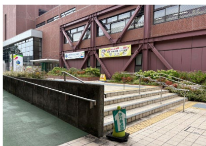
【入口前タイル及びスロープの滑り止め施工】
