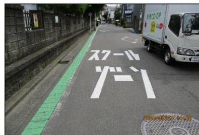
【通学路 路面標示の補修】
