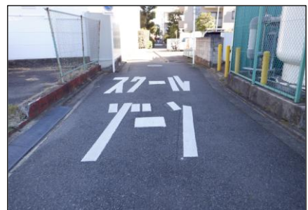
【通学路 路面標示の補修】
