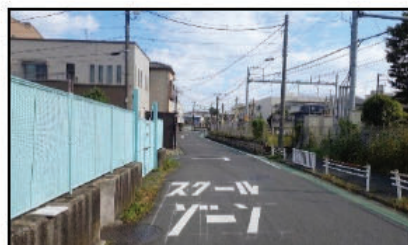
通学路 路面標示の補修
