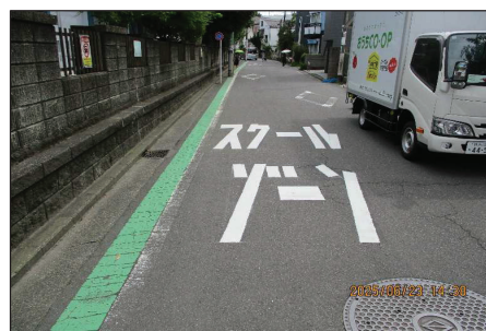
【通学路 路面標示の補修】
