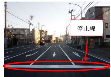
写真4 道路標示完成
