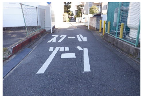
通学路 路面標示の補修
