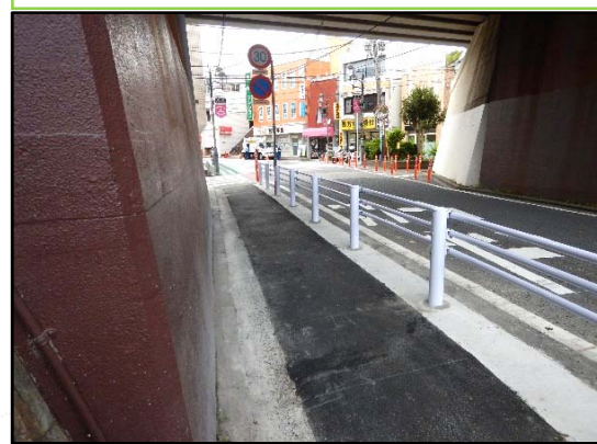
⑥【ガード下】歩道拡幅+ガードパイプ を設置
