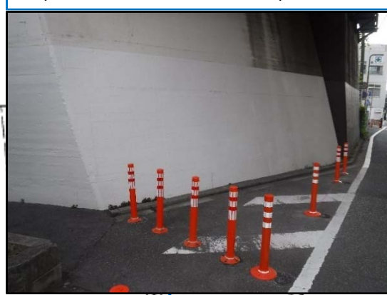
④ポストコーン設置 (歩行者をトンネルへ誘導)
