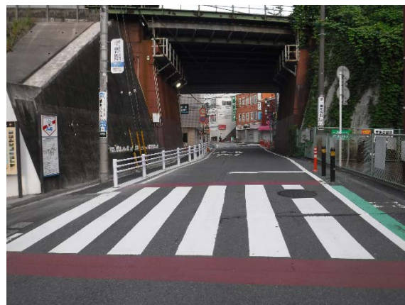
写真4 【対策後】京急富岡駅東口の横断歩道幅を広げベンガラ塗装で強調
