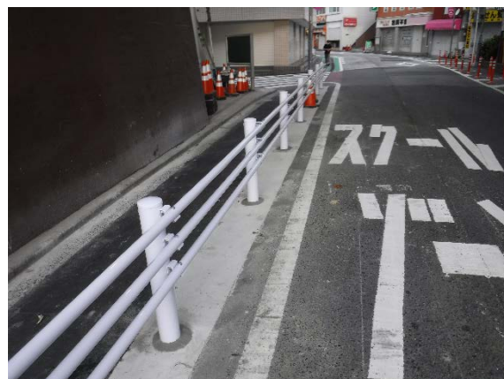
写真2 【対策後】ガードパイプ
