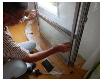
窓ガラス飛散防止フィルム 施工作業
