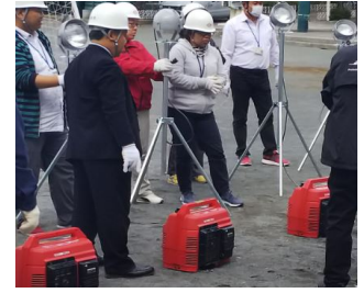
【地域防災拠点の発電機・投光器】
