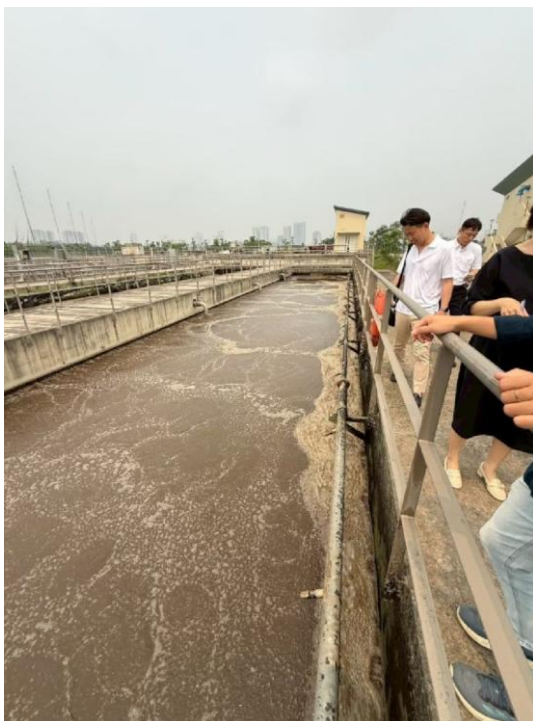
処理場内の様子
