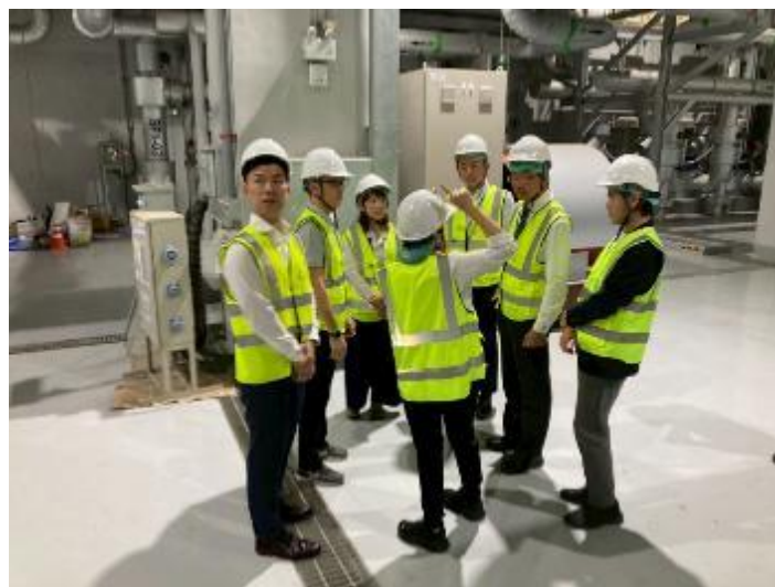
冷房設備の入る機械室で説明を受ける様子
