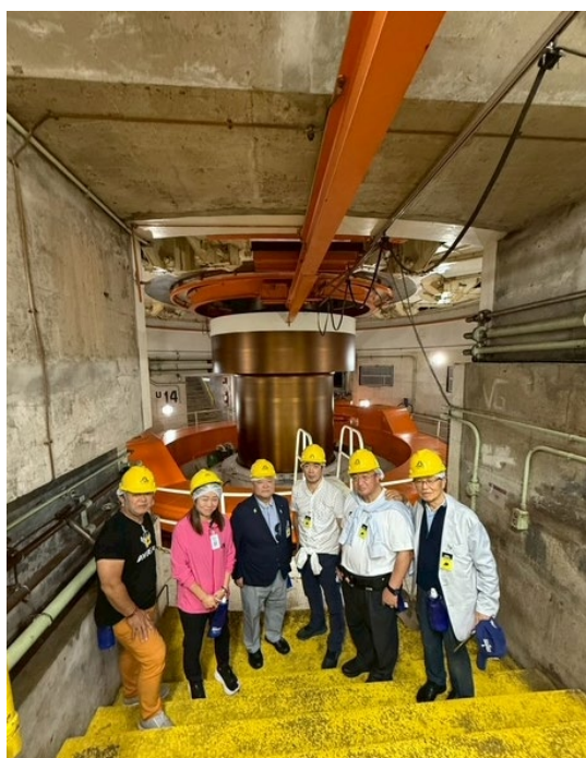
発電機内部・タービン上部での視察の様子
