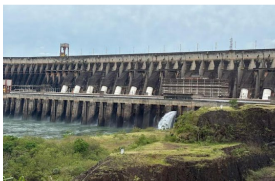
放水路付近のダム外観
