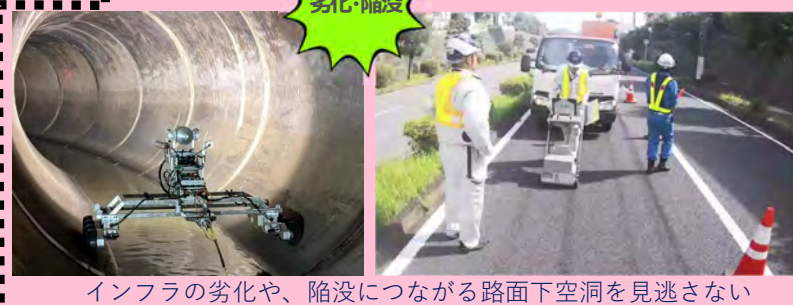
インフラの劣化や、陥没につながる路面下空洞を見逃さない
