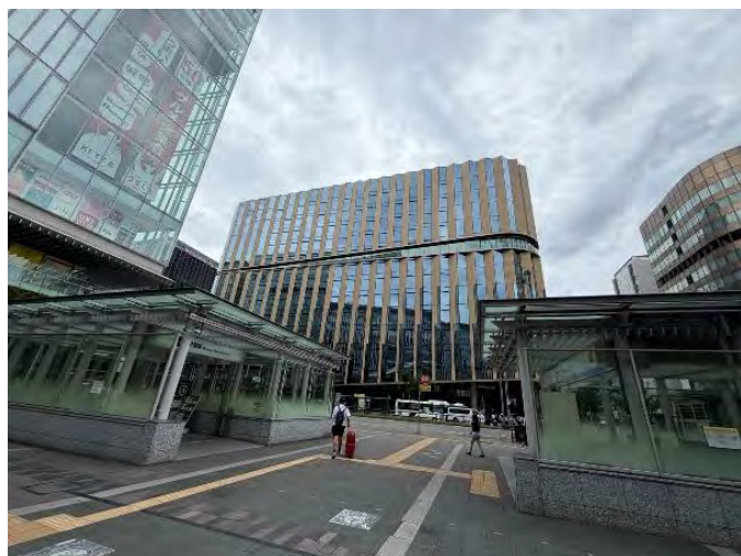
(博多駅周辺の都市機能・駅前空間を現地視察)
