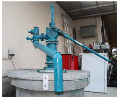
▲防災用井戸のポンプ整備
