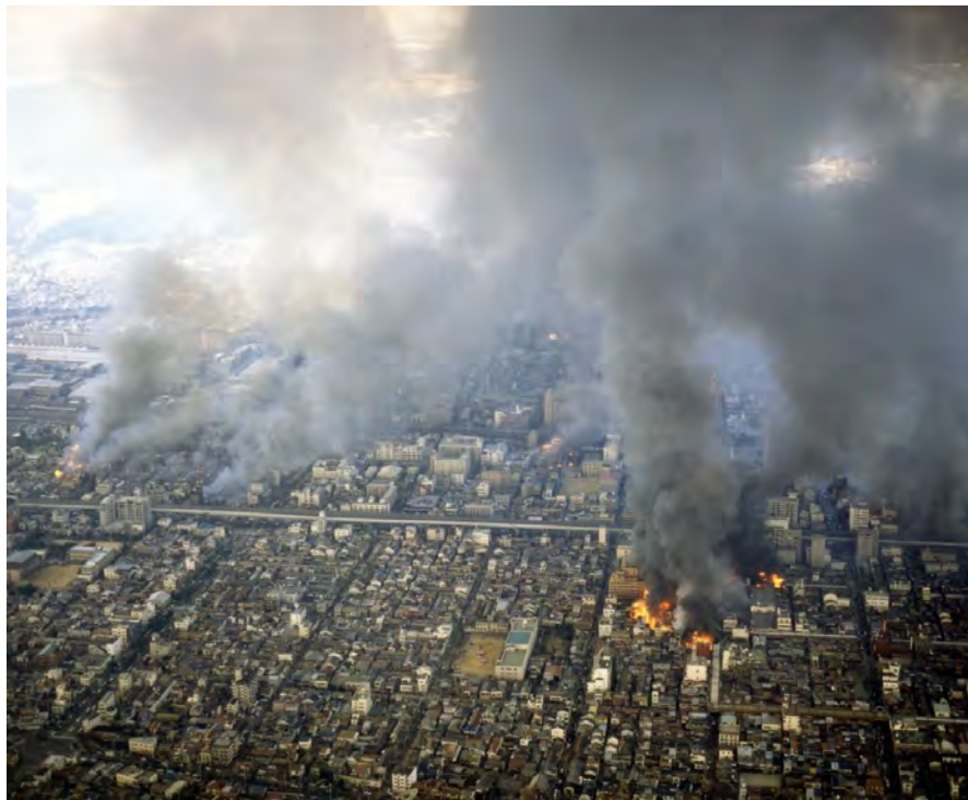
電気火災などにより同時多発的に出火 （地震直後・通電再開時…）
