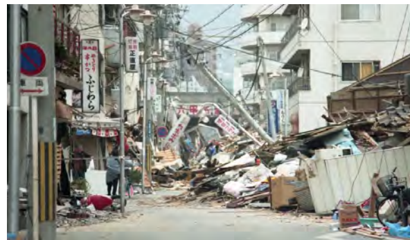
火災や建物倒壊により通行困難 避難や救助、消火も困難
