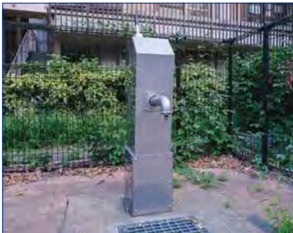
新横浜第一公園災害用井戸
