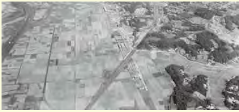
新幹線工事中
