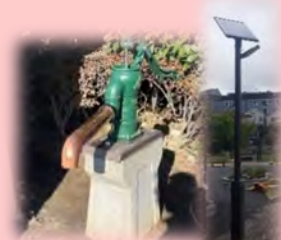
防災井戸・ソーラー電源
