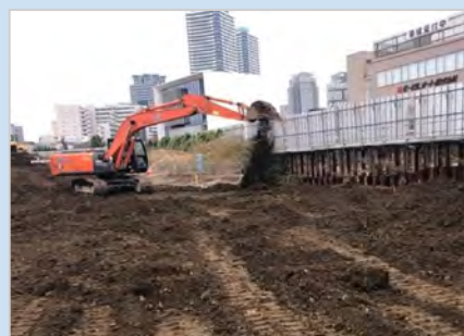
埋立工事の様子
