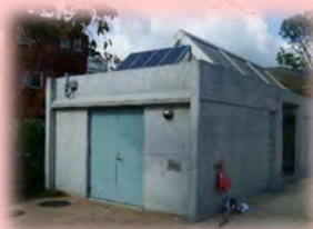
倉庫付き災害用トイレ
