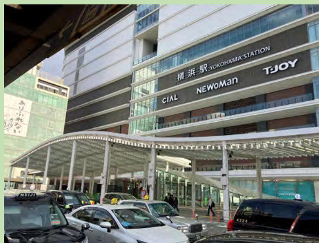
▲横浜駅中央西口駅前広場：多くの来街者を迎え入れる玄関口にふさわしいにぎわいのある空間を創出するため、舗装工事や、エリマネ活動に活用可能な設備（電気トラフ等）を整備
