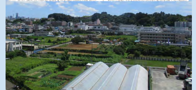
施行検討区域（写真奥が小机駅）
