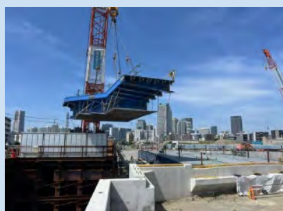
橋梁架設の様子
