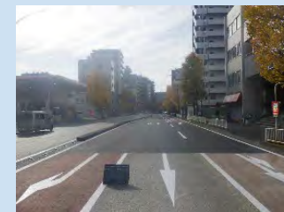
寿町周辺地区の道路整備
