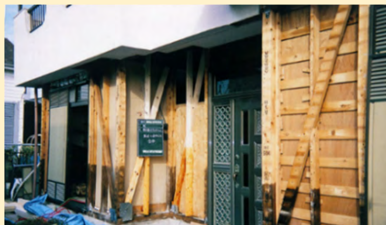
木造住宅の耐震工事施工状況
