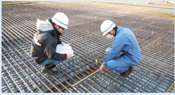
現場検査の様子
