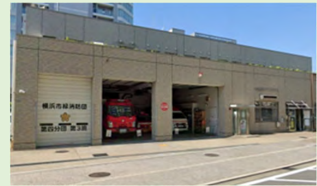
長津田消防出張所
