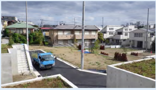
開発許可による戸建て分譲地
