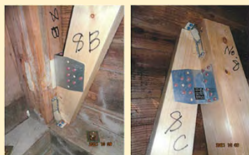
耐震改修工事金物施工状況
