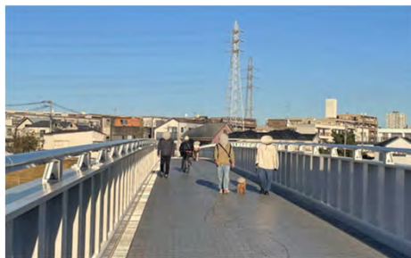
令和7年3月に開通した鶴見川人道橋(鶴見区)
