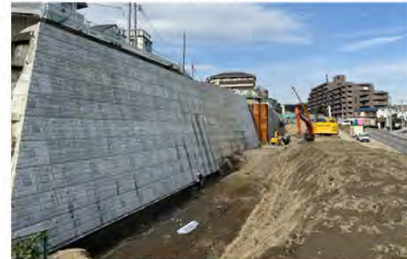
環状4号線側の擁壁工事状況
