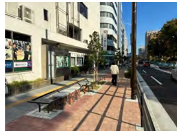
みなと大通りの歩道拡幅状況
