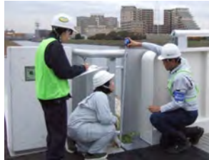
《関係団体による被害状況緊急調査の訓練》 神奈川県測量設計業協会横浜支部・ 横浜市地質調査業協会・ 横浜市建設コンサルタント協会
