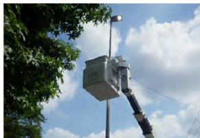
道路照明灯の点検
