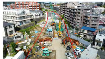
トンネル坑口付近の工事状況
