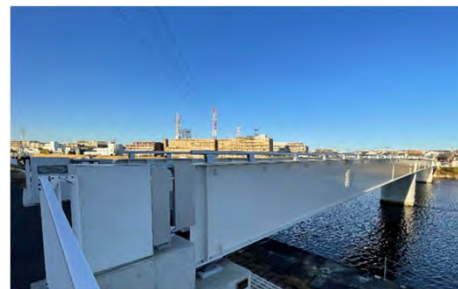
鶴見川人道橋(鶴見区)の全景
