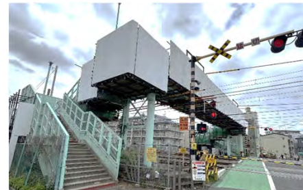
古市場人道橋（鶴見区）：補修工事
