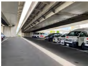
【高架下等有効活用事業】 中区かもめ町
