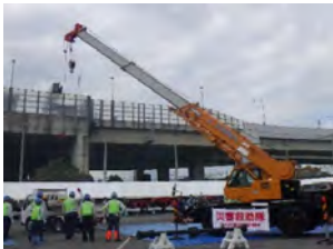
《横浜市総合防災訓練》 横浜建設業協会（青葉区会）・ 青葉土木事務所
