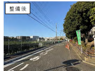
【泉区】市道新橋第276号線
