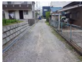
私道整備助成実施前（都筑区）
