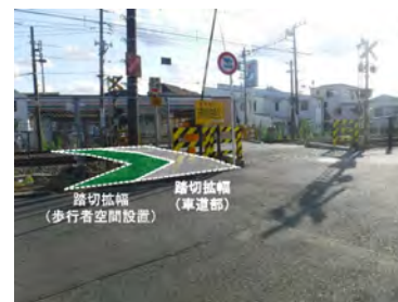
法隆寺踏切（港北区：J R 東日本横浜線）
