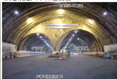
※2 釜利谷庄戸トンネル掘削状況
