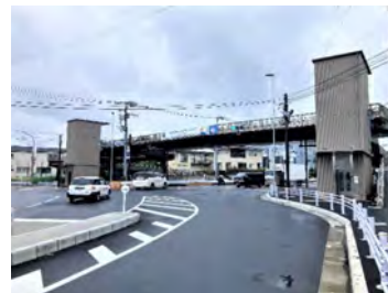
国道1号(不動坂工区)
