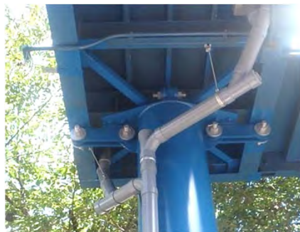
赤門町歩道橋（中区）： 落橋防止装置の設置
