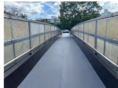
川上町歩道橋(戸塚区):橋面舗装補修
