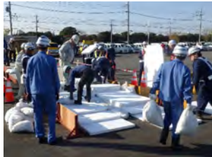
《道路啓開合同訓練（段差の解消訓練）》 横浜建設業協会（金沢区会）・金沢土木事務所
