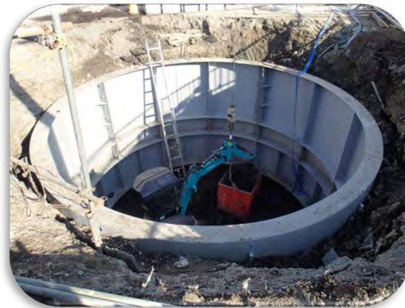
《防火水槽新設工事》
