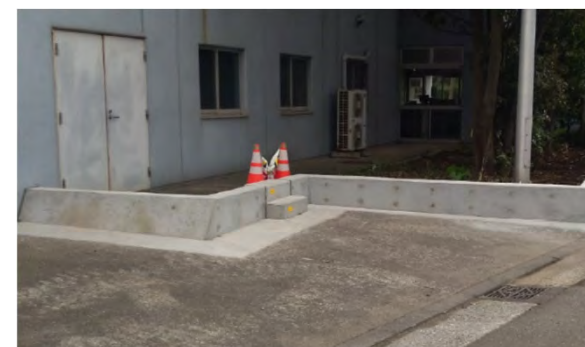
浸水対策(止水壁設置)事例
