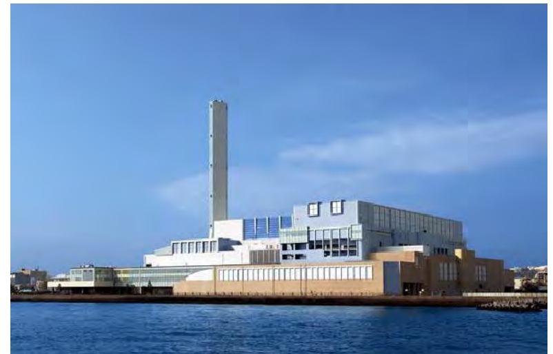
長寿命化工事中の 「JFE横浜金沢マリンエネルギーセンター(金沢工場)」
