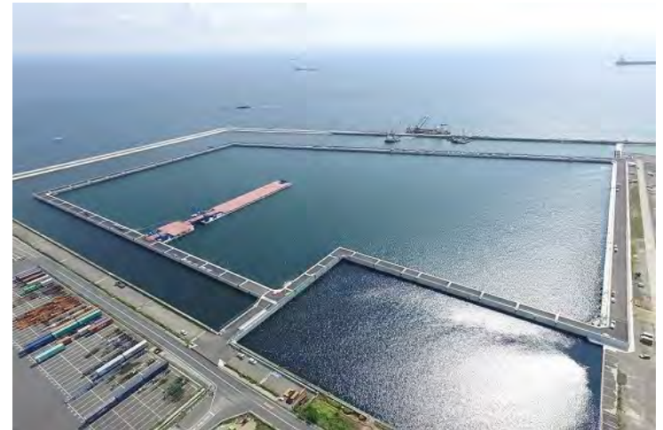
南本牧第5ブロック廃棄物最終処分場
