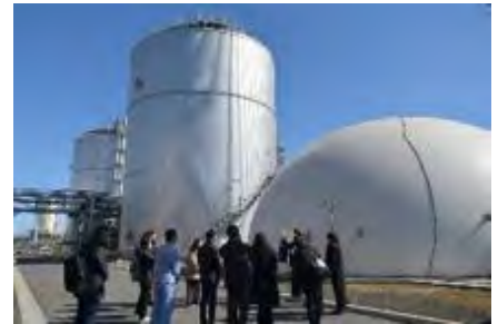
中部浄化センター下水汚泥等利活用施設
