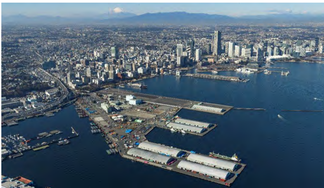
【山下ふ頭全景写真】
