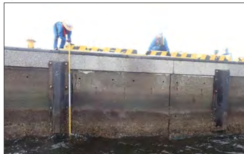
【港湾施設等の点検 岸壁防舷材調査】
