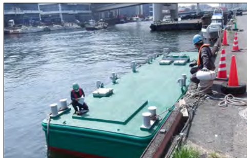
【港湾施設等の修繕 浮棧橋補修】
