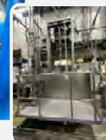
食肉機械設備例 （昇降作業台）
