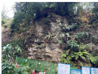
【岩接着施工前】
