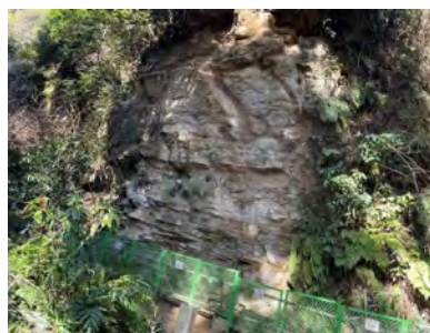
【岩接着施工後】
