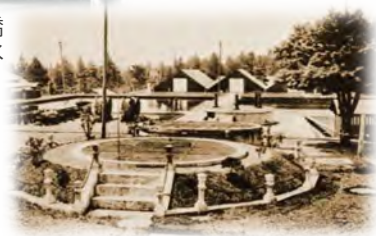
川井浄水場接合井(大正4年)
