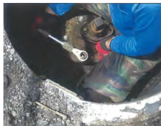
仕切弁附属設備修理工事
