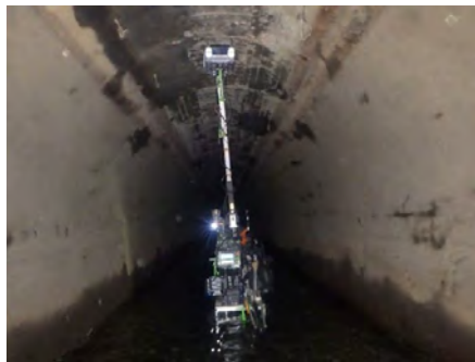
導水施設の健全度調査
