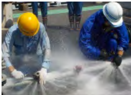
管路研修施設での研修
