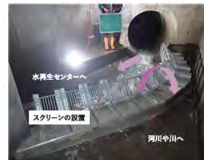
雨水吐の改良状況
