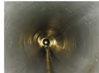
下水道管 再整備工事後
