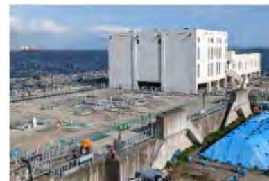
高度処理施設 施工現場 (南部水再生センター)
