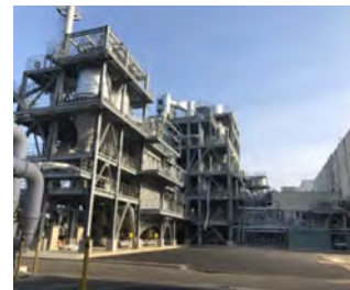
汚泥焼却炉 （北部汚泥資源化センター）
