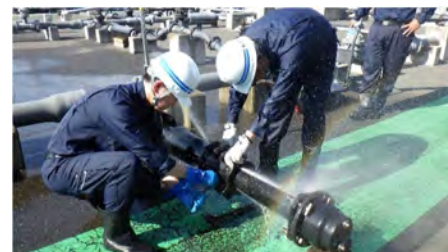
水道局漏水修理体験型研修
