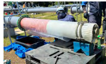
汚泥圧送管更生工法の開発における デモ施工の様子
