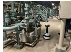
自動巡回点検実験の様子
