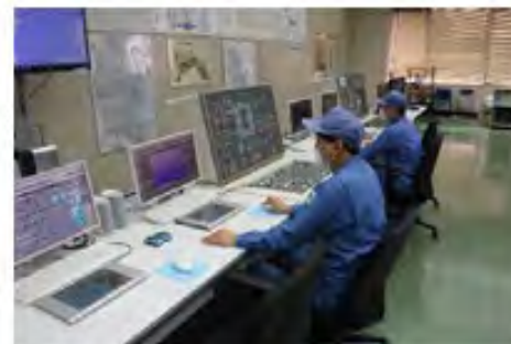
中央操作室での運転監視
