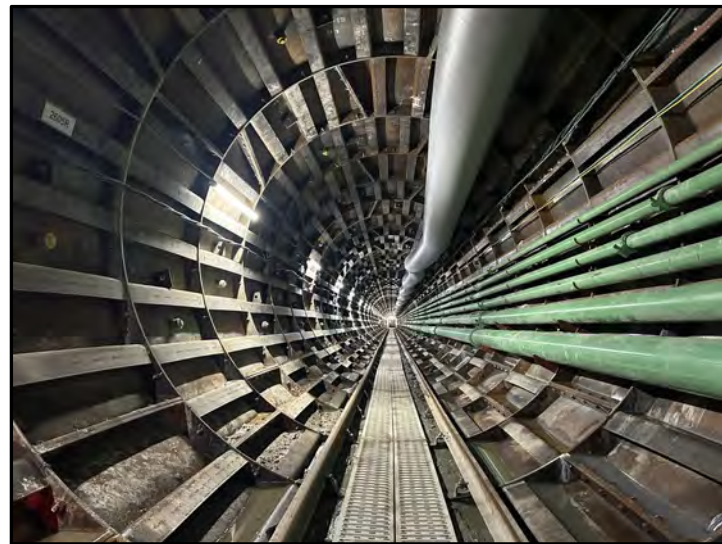
写真3 トンネル坑内 (川井接合井)
