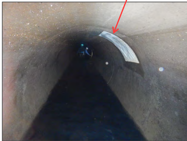
部分修繕の例
