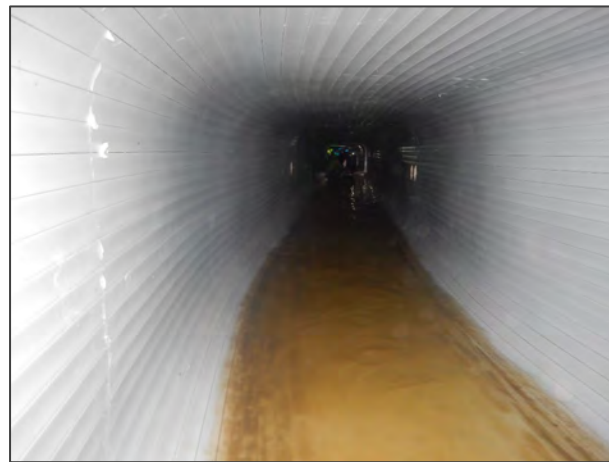
管更生工法による改築の例
