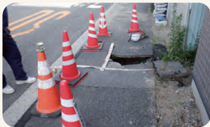
取付管に起因する陥没の状況
