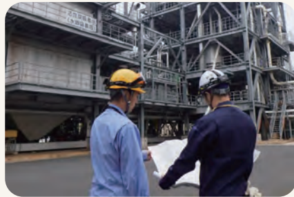
修繕工事の発注と監督
