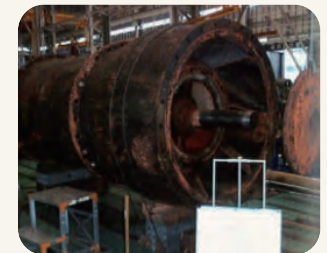
主ポンプ設備の修繕
