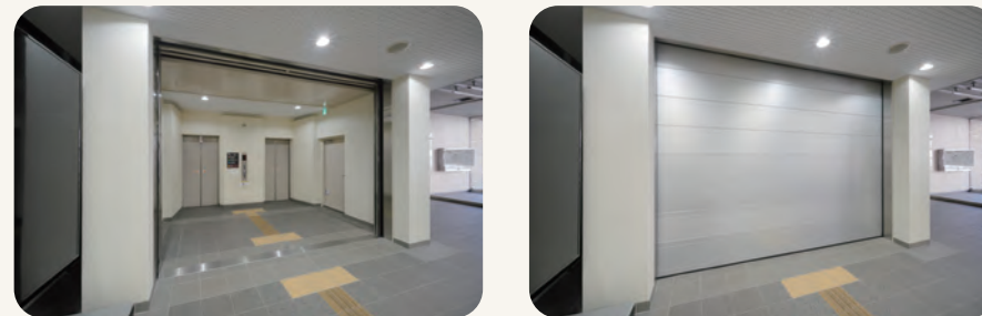
防水扉の設置状況(戸塚ポンプ場)
