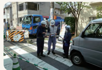
請負業者及び監督員への安全確認状況
