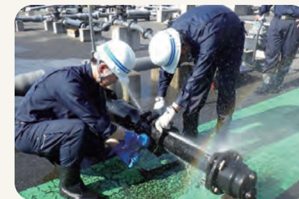
水道局漏水修理体験型研修
