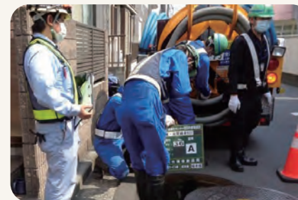
北部汚泥資源化センター包括的管理委託 送泥管点検
