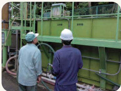
工場への立入検査の様子
