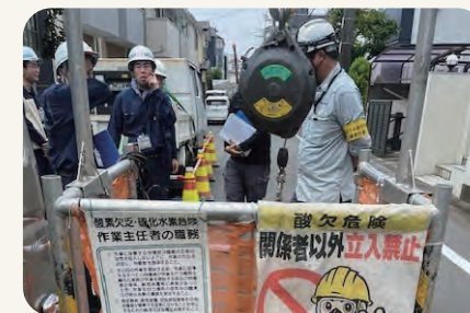
現場点検状況
