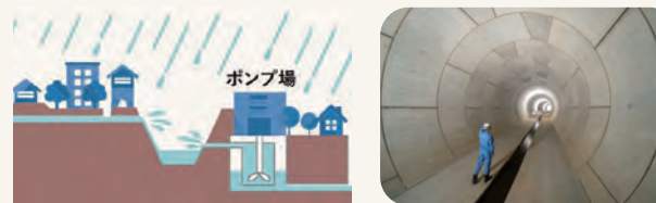
雨水貯留施設(新羽末広幹線)
