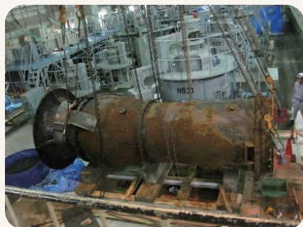
再整備前のポンプ設備
