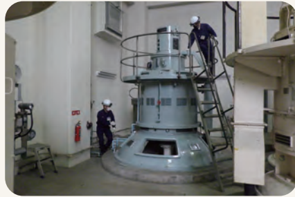
主ポンプ設備の点検
