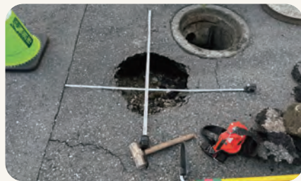
取付管に起因する陥没の状況
