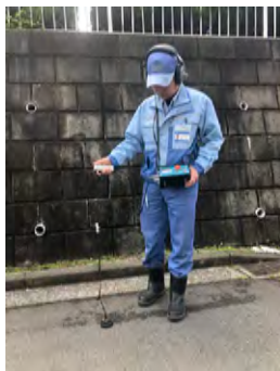
漏水調査の様子
