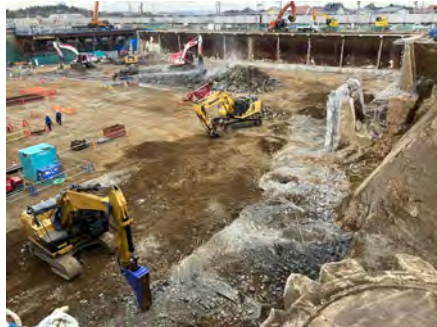
西谷浄水場再整備(1号配水池)
