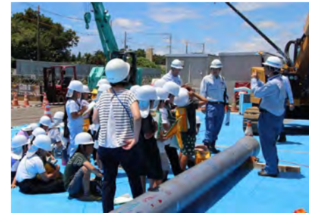
小学生向け工事見学会
