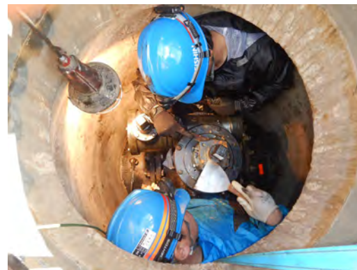
仕切弁調査の様子
