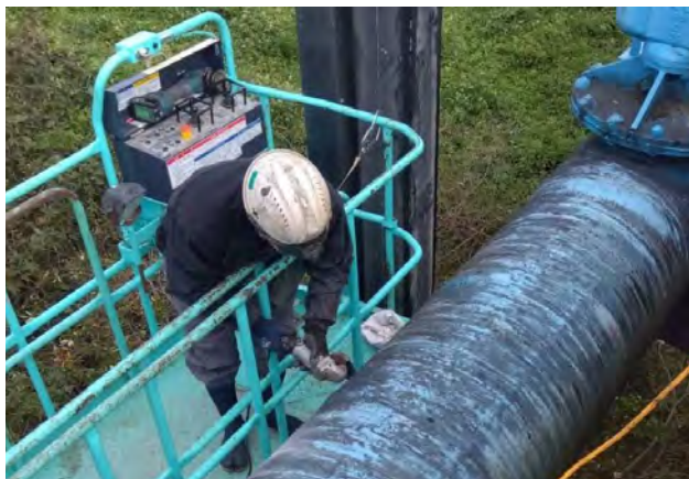
水管橋調査の様子
