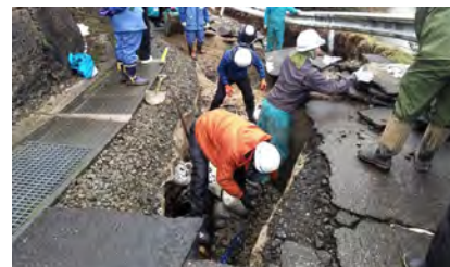
被災地での応急復旧
