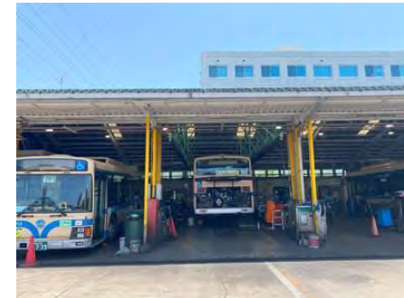
港北営業所車両整備工場
