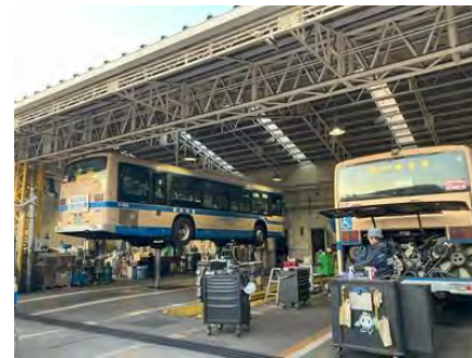
緑営業所車両整備工場
