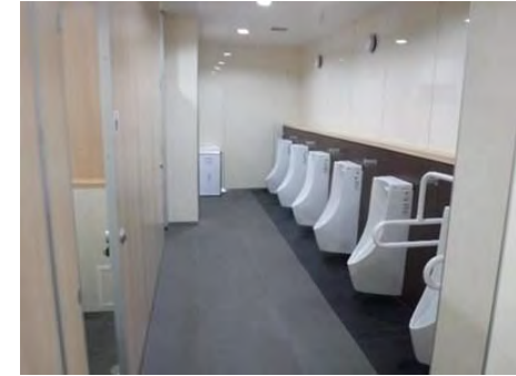
センター南駅トイレ（6年度施工）
