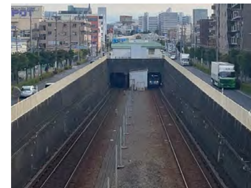
新羽駅～北新横浜駅間
