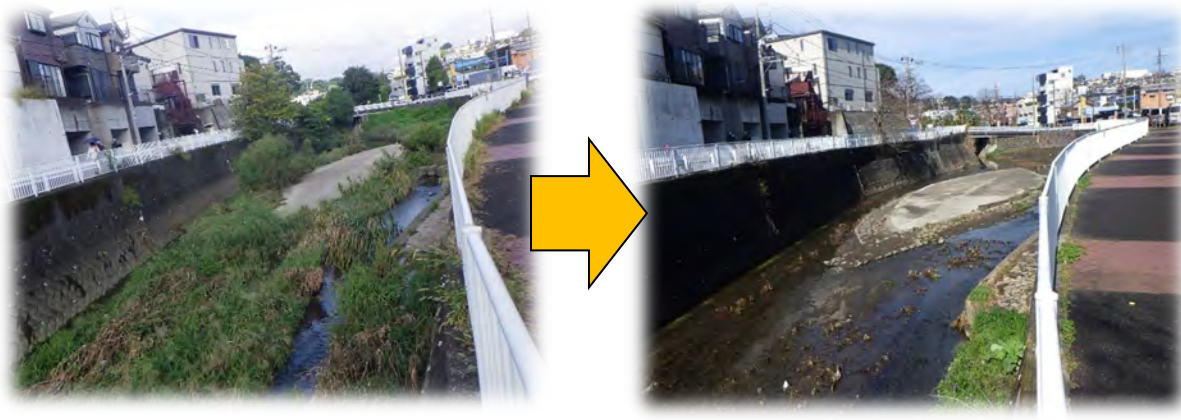
河道内の土砂堆積撤去（今井川）前後
