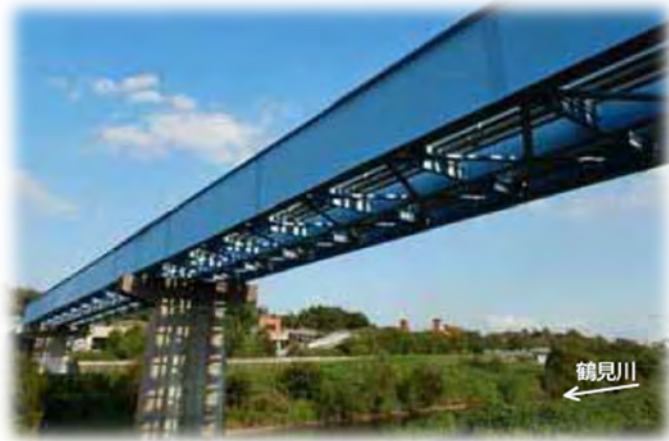
水管橋の耐震化（新羽ポンプ場）
