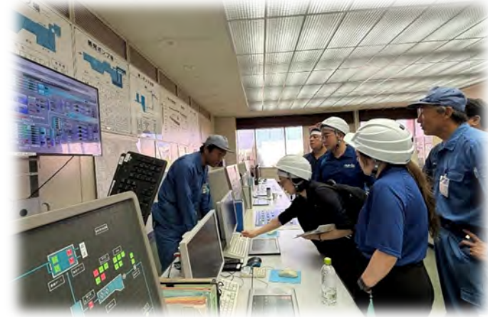
PUB（シンガポール公益企業庁）による北部汚泥資源化センター視察
