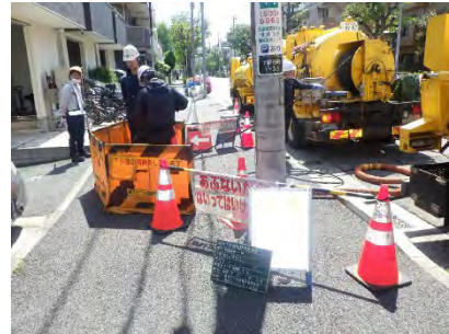
下水道管清掃状況
