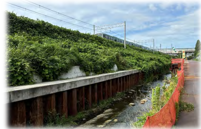
河川改修（護岸整備）（今井川）
