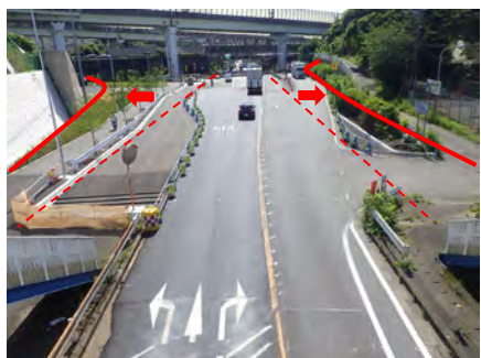
八王子街道の 拡幅整備
