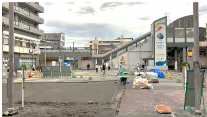
保水性舗装の整備状況
