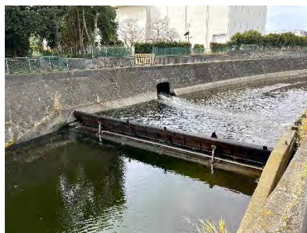
水田の取水施設(左:取水堰／右:更新したポンプ) (青葉区)
