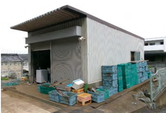
出荷調製施設・農機具格納庫(神奈川区)
