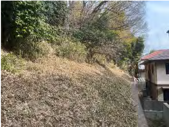
維持管理の助成を行った樹林地(港北区)
