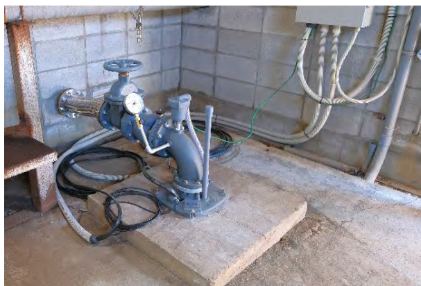
畑の井戸の設備更新(泉区)
