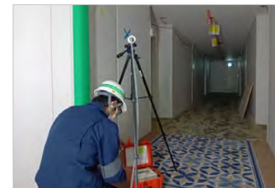
アスベスト濃度の測定
