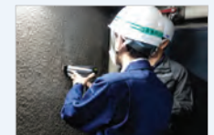
図 4-33 ASAとの災害対応訓練 (アスベスト調査)
