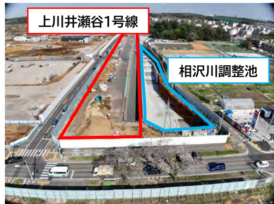
【①上川井瀬谷1号線・相沢川調整池工事状況】
