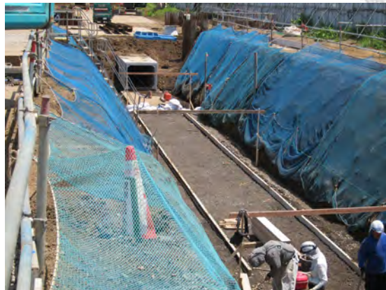
【②下水道工事状況】
