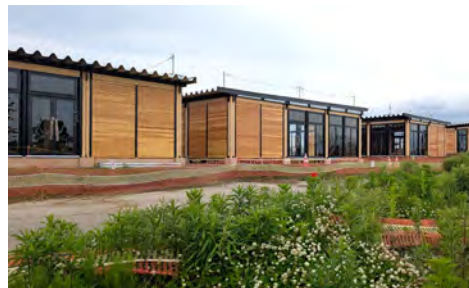
【協会の建築工事(カI、J、K等)】
