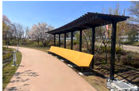
【④整備済の園路・休憩施設】
