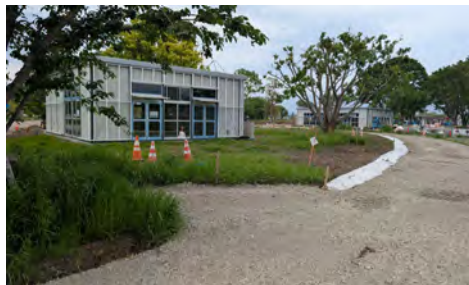
【協会の建築工事(ファストフード)】
