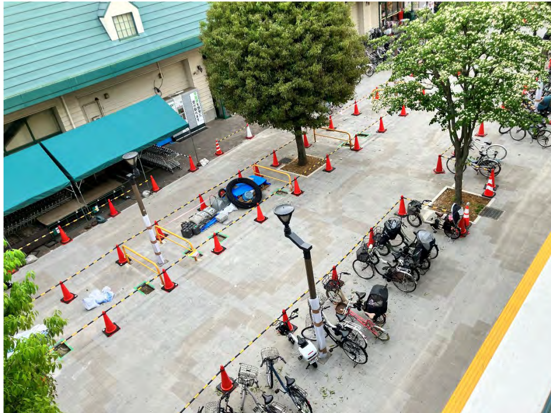
保水性舗装による舗装整備の状況(瀬谷駅北口駅前広場)
