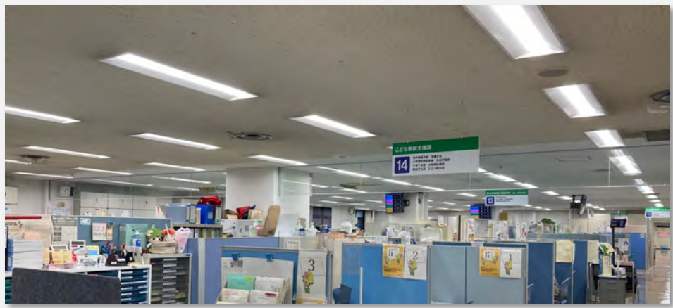
港北区総合庁舎 (7年度LED化工事)
