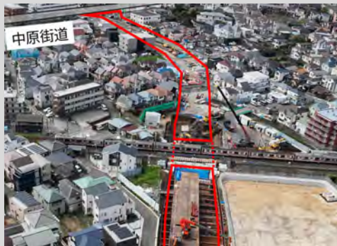
工事状況 (瀬谷地内線鉄道交差部)
