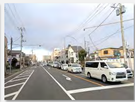
交差点改良(右折レーン延伸)
