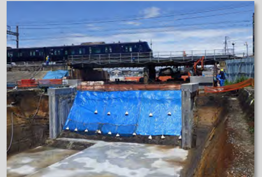
工事状況 (擁壁築造)
