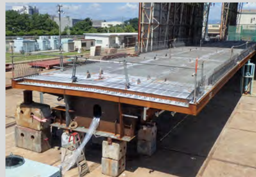
工事状況 (橋桁製作)
