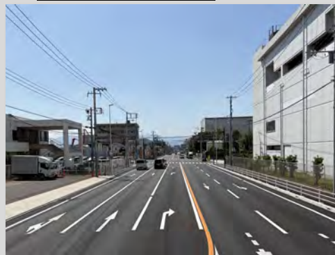
工事状況 (目黒交番前交差点付近)
