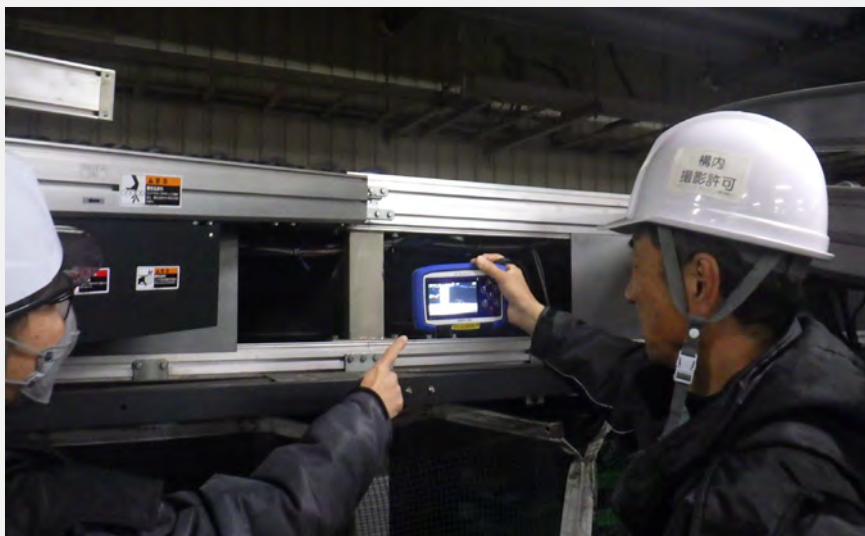
現場確認の様子
