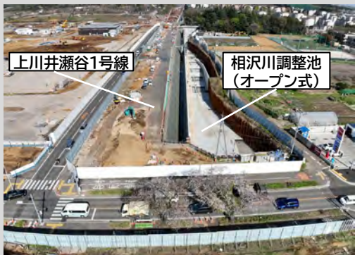
上川井瀬谷1号線等の工事状況
