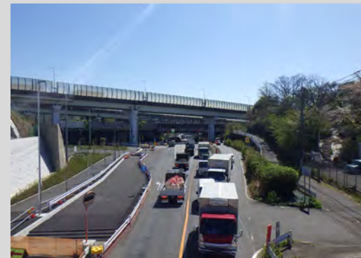
工事状況 (上川井IC付近)
