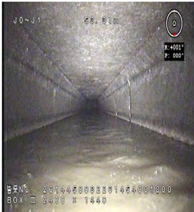
下水道管内の状況(腐食の一例)
