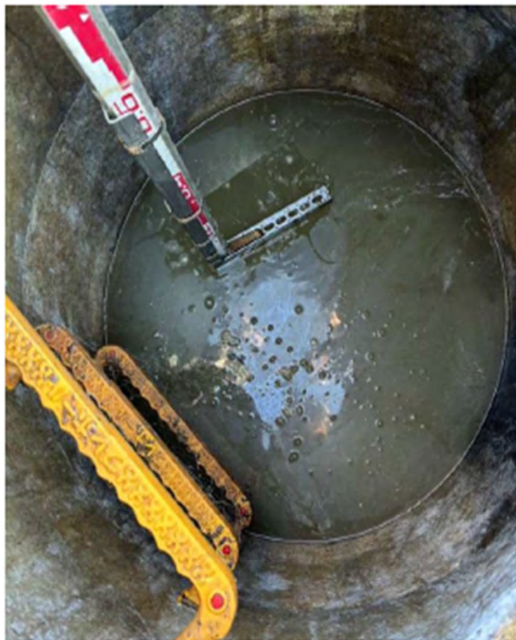
人孔内土砂閉塞(羽咋市)
