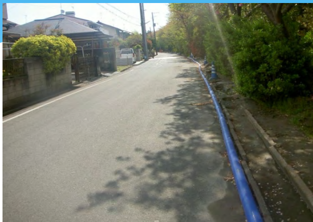
仮設配管 (千葉県習志野市)
