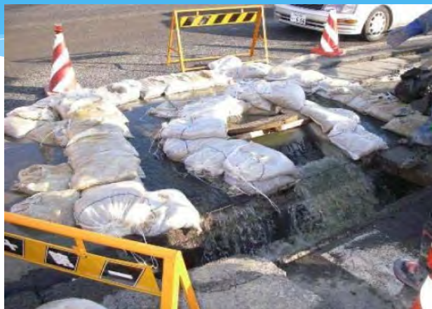
土のうによる仮設水路 (宮城県多賀城市)
