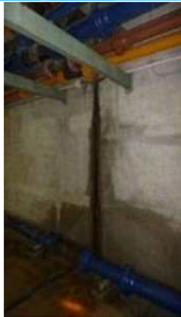
反応タンク継ぎ目部破損による漏水
