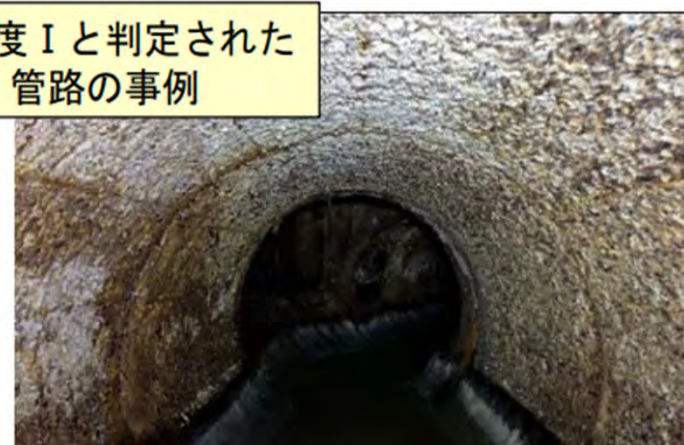
管の腐食から緊急度Ⅰと判定
