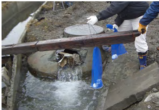
固形塩素での消毒状況 (岩手県大船渡市)
