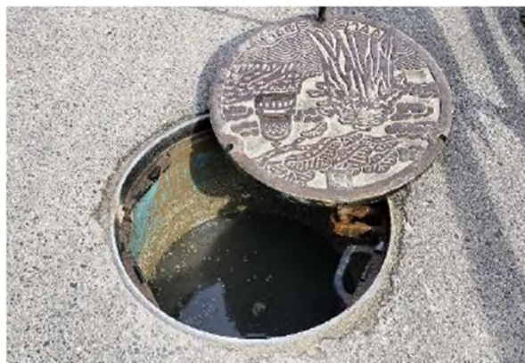
下水道管路の滞水状況
