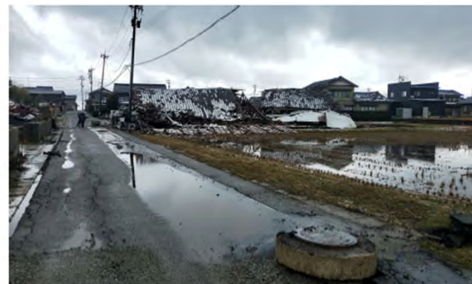
圧送管の破損が原因と想定される路面変状
