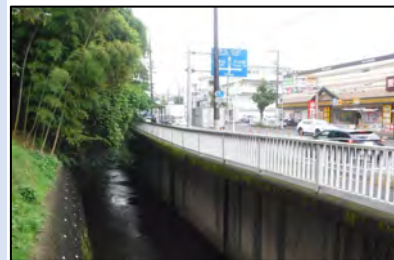
緊急輸送路に隣接した 護岸(特殊堤)
