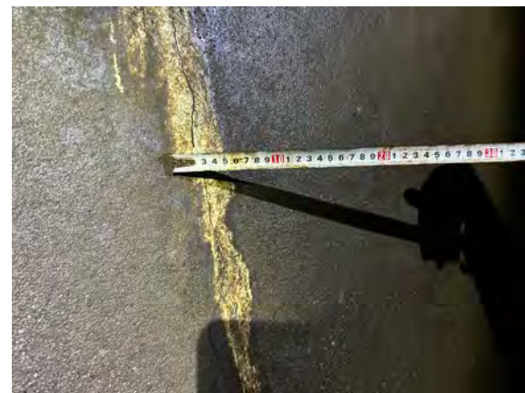
下水道管内の状況（クラックの一例）
