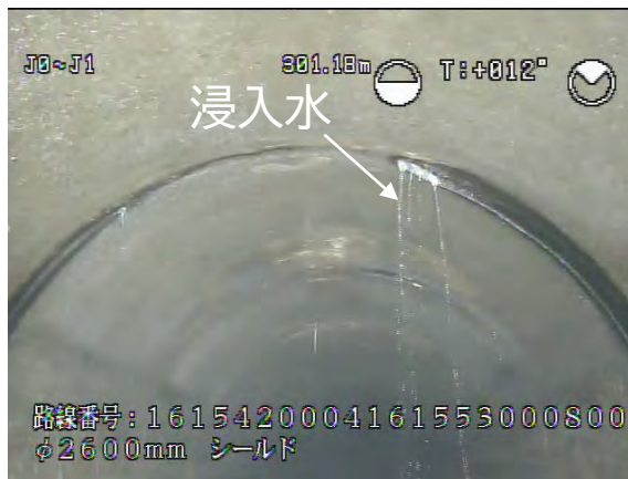
下水道管内の状況（浸入水の一例）
