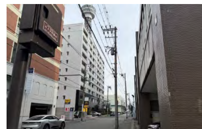
狭い歩行空間に電柱や電線がある
