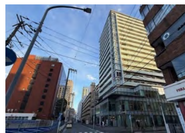
水町通りに面した共同住宅
