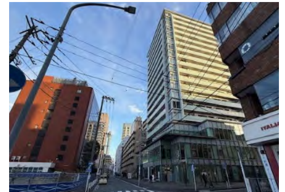
水町通りに面した共同住宅
