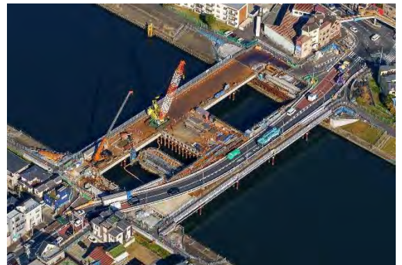
末吉橋(鶴見区): 橋脚築造工事
