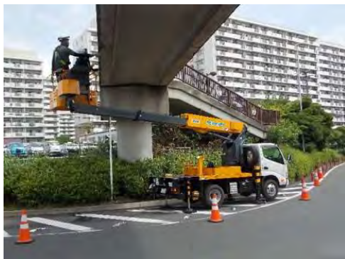
劣化状況の近接目視 小港橋歩道橋（中区）
