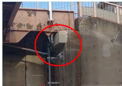
三ツ沢第3歩道橋（西区）：橋台の縁端拡幅 6年2月完成
