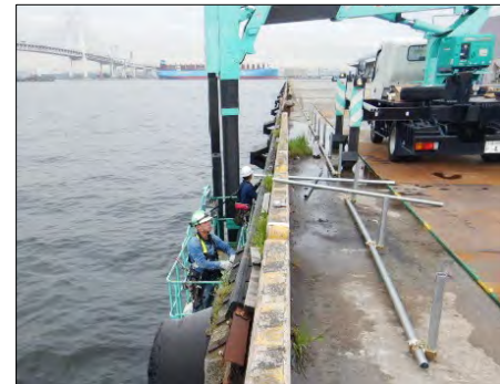
【岸壁補修工事】
