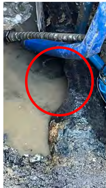
写真-2 水道管の破裂状況
