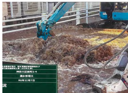
写真-1 漏水量が最大時の様子
