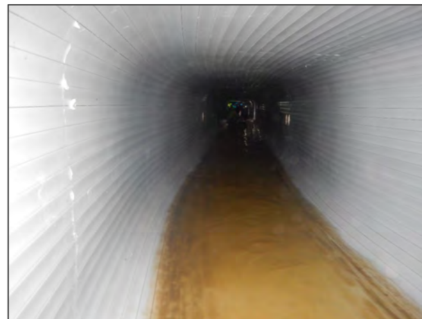
管更生工法による改築の例
