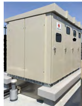
高圧一括受電導入済マンションの受変電設備
