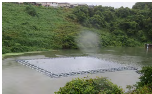
フロート式太陽光発電（雨水流入時）
