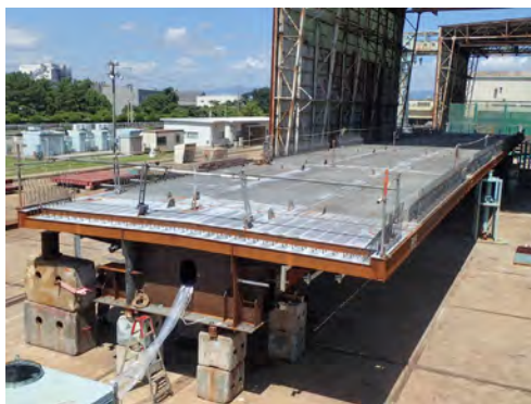
【②工場における橋桁製作状況】
