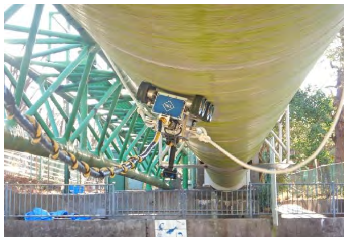
ロボットによる水管橋の点検
