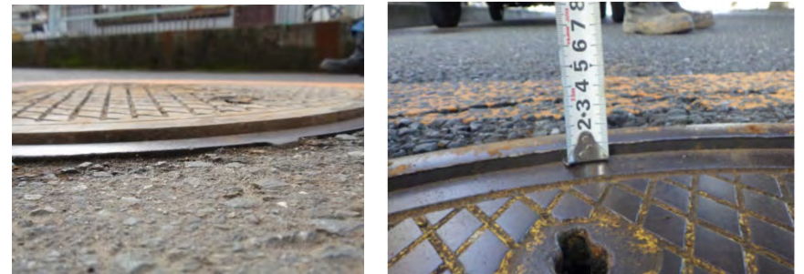
○路面との段差、受枠との段差の判定
